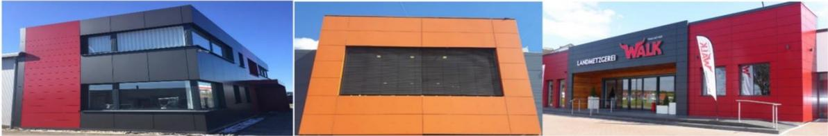
MAAS PLANBOND Aluminium-Verbundplatten bestehen aus zwei 0,5 mm dicken, mit hochwertigen Lacken veredelten Aluminium-Deckblechen und einem schwer entflammaren bzw. nicht brennbaren Kernmaterial. Sie zeichnen sich durch leichte Verarbeitung, Formbarkeit, exzellente Planheit, Biegesteifigkeit und Witterungsbeständigkeit aus. Darüber hinaus sind sie schlag- und bruchfest und sehr langlebig. Das ideale Material für anspruchsvolle Fassadengestaltung sowohl für Bestands- als auch Neubau.
